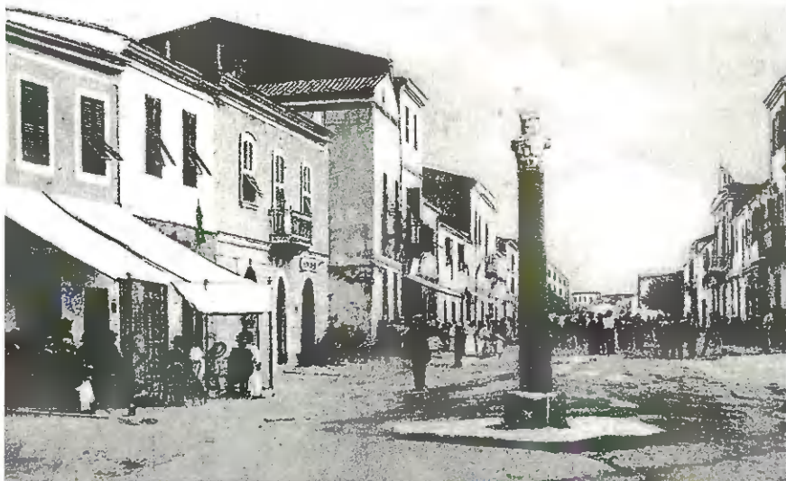
Fig. 55 Porto Torres. Piazza Colombo: la colonna che indica l'inizio della strada per Karales.
