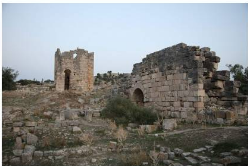
Figg. 18-19: La torre SE vista dall'alto e dall'interno del forte bizantino (Salvatore Ganga).
