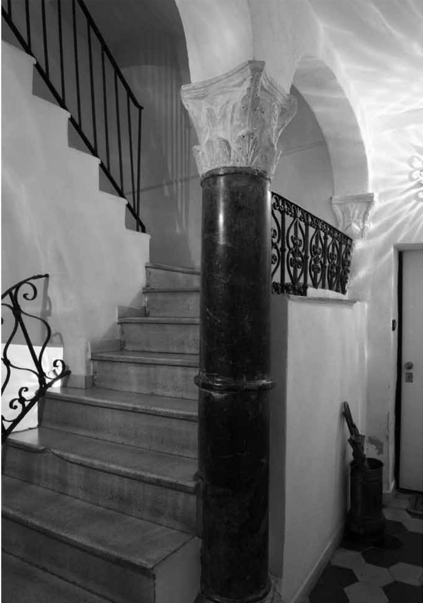
Fig. 8. Sassari, piazza Tola. Vano scale del palazzo Luguia. Parti di due colonne con capitello corinzieggiante.
