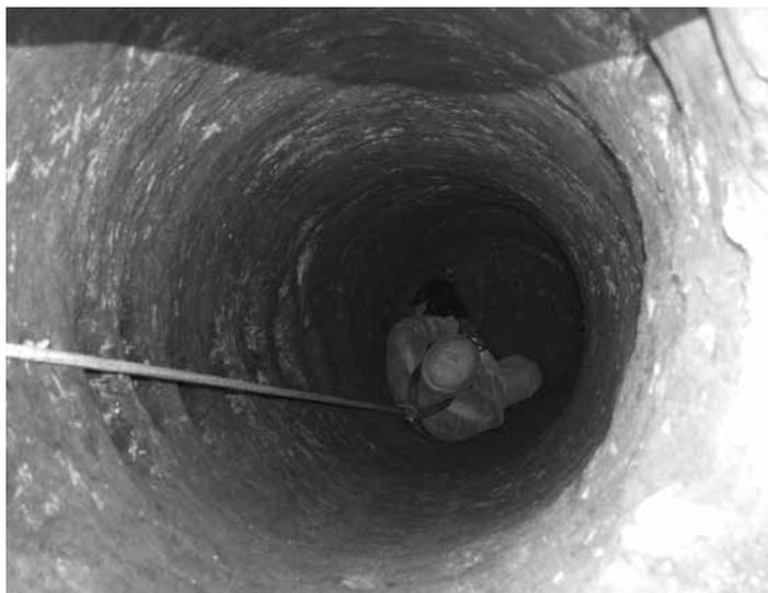
Fig. 19. Sassari. Il pozzo di via Sebastiano Satta in corso di scavo.
