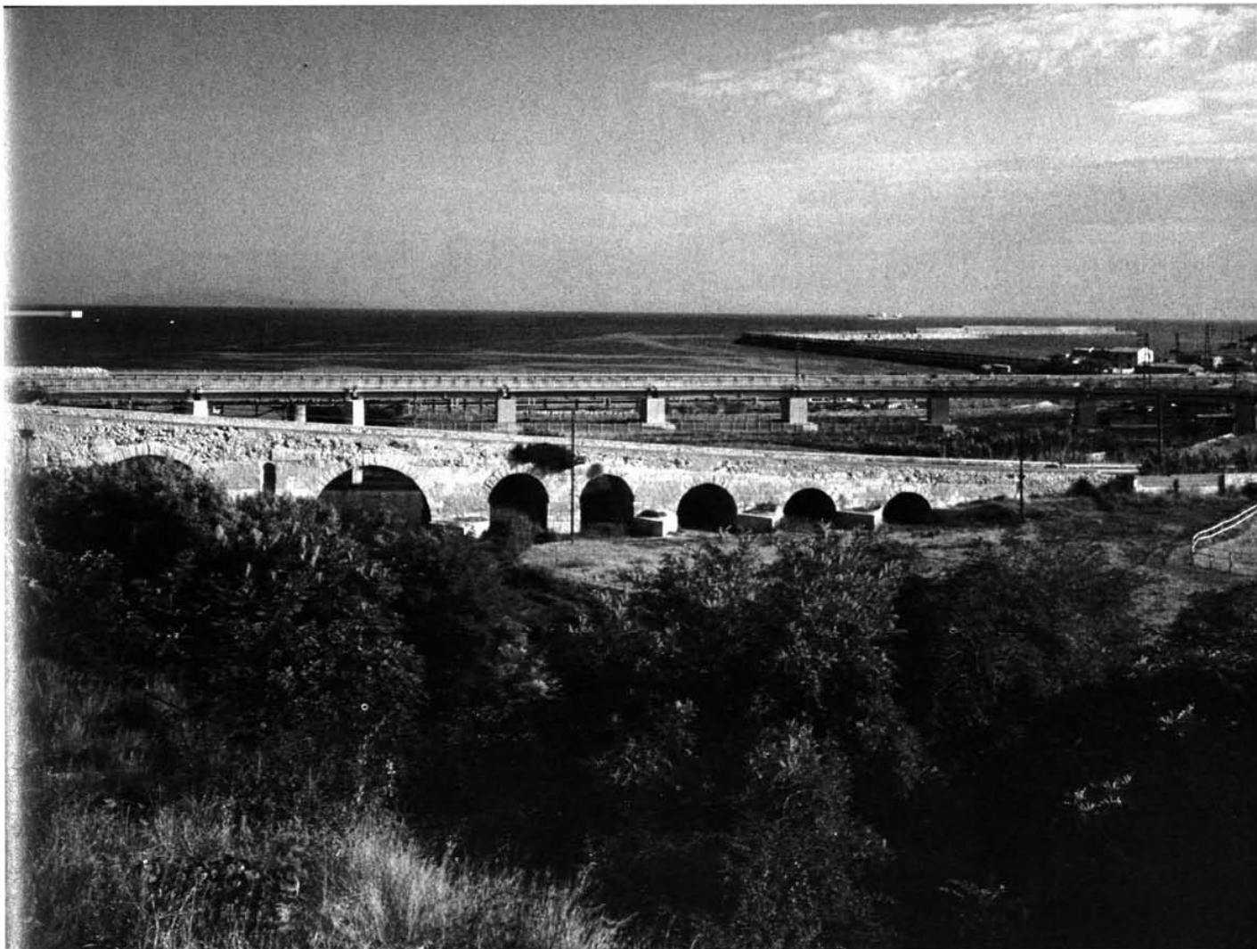
68. Il ponte romano di Porto Torres. A sette luci, ancora intatto dopo quasi venti secoli, era collocato nella parte iniziale della grande strada lungo la costa occidentale dell'isola. La struttura richiama il ponte di Augusto a Rimini, e risale ai primi tempi della colonia di Turris Libisonis.
