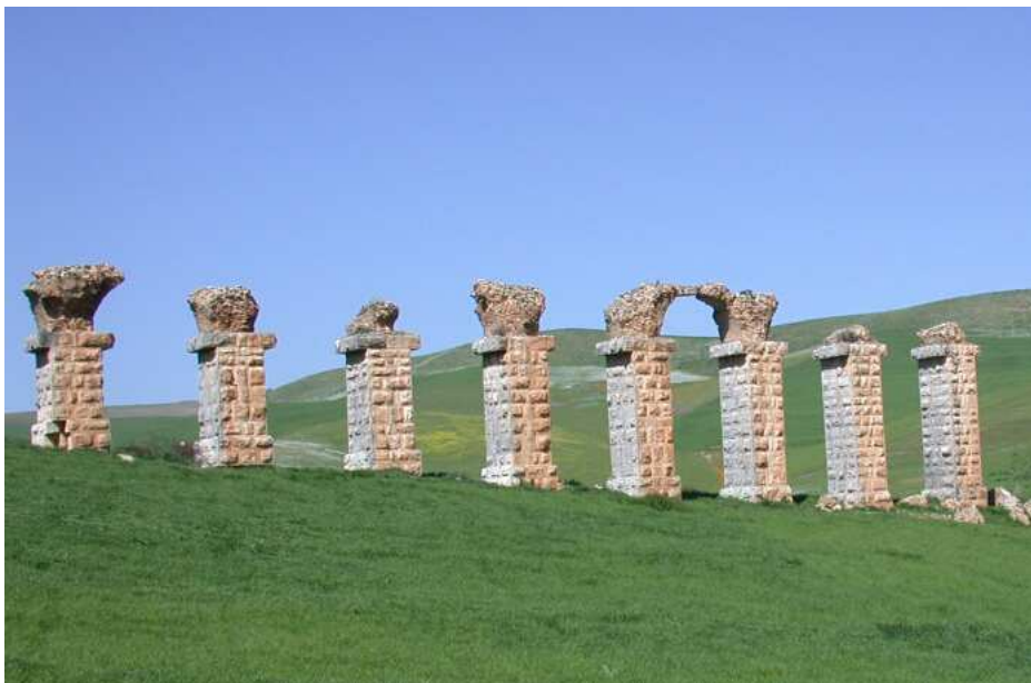
fig. 6: aqueduc de Thugga (photo S. Ganga).
