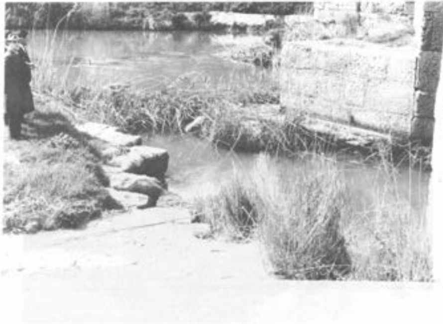
Il ponte sul Rio Mannu, detto comunemente «Ponte Romano». Sotto le arcate si conservano porzioni della pavimentazione in lastre di trachite (Foto: Soprintendenza Archeologica per le province di Sassari e Nuoro - Neg. U. 24.15).
