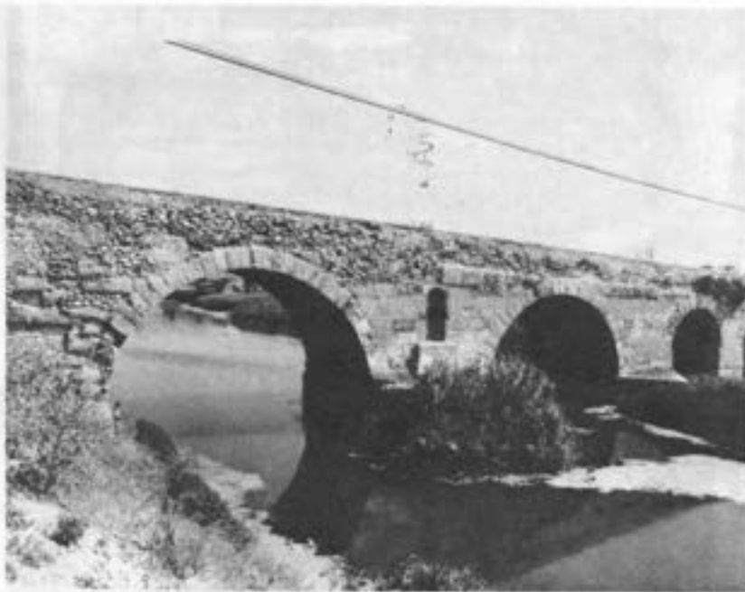
Il ponte sul Rio Mannu. Le sette arcate sono caratterizzate da un raggio decrescente da W verso E. Tra la seconda e terza arcata è stata ricavata una nicchia nei due versanti (Foto: Soprintendenza Archeologica per le province di Sassari e Nuoro - Neg. DH. 16.3).
