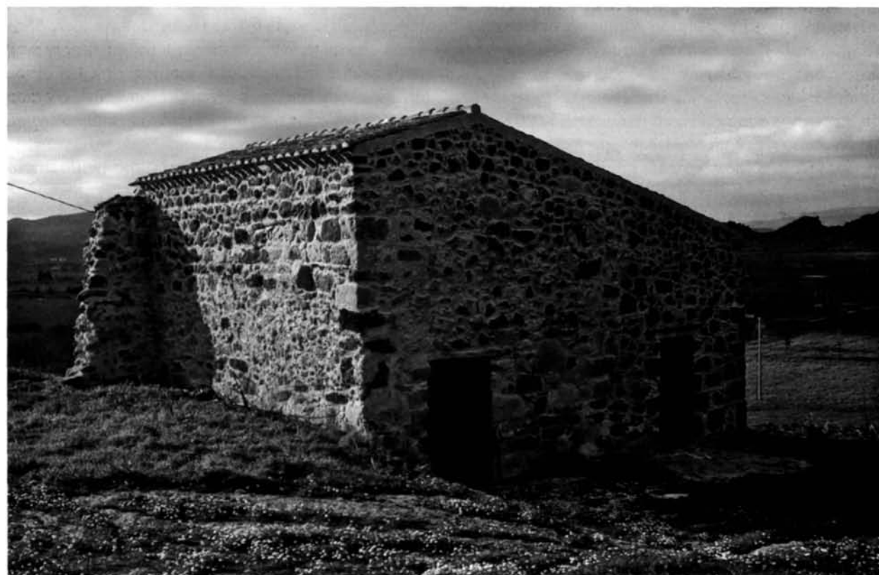
Fig. 2 - L'edificio di Sas Presones di Rebeccu (Bonorva) dopo il restauro.
