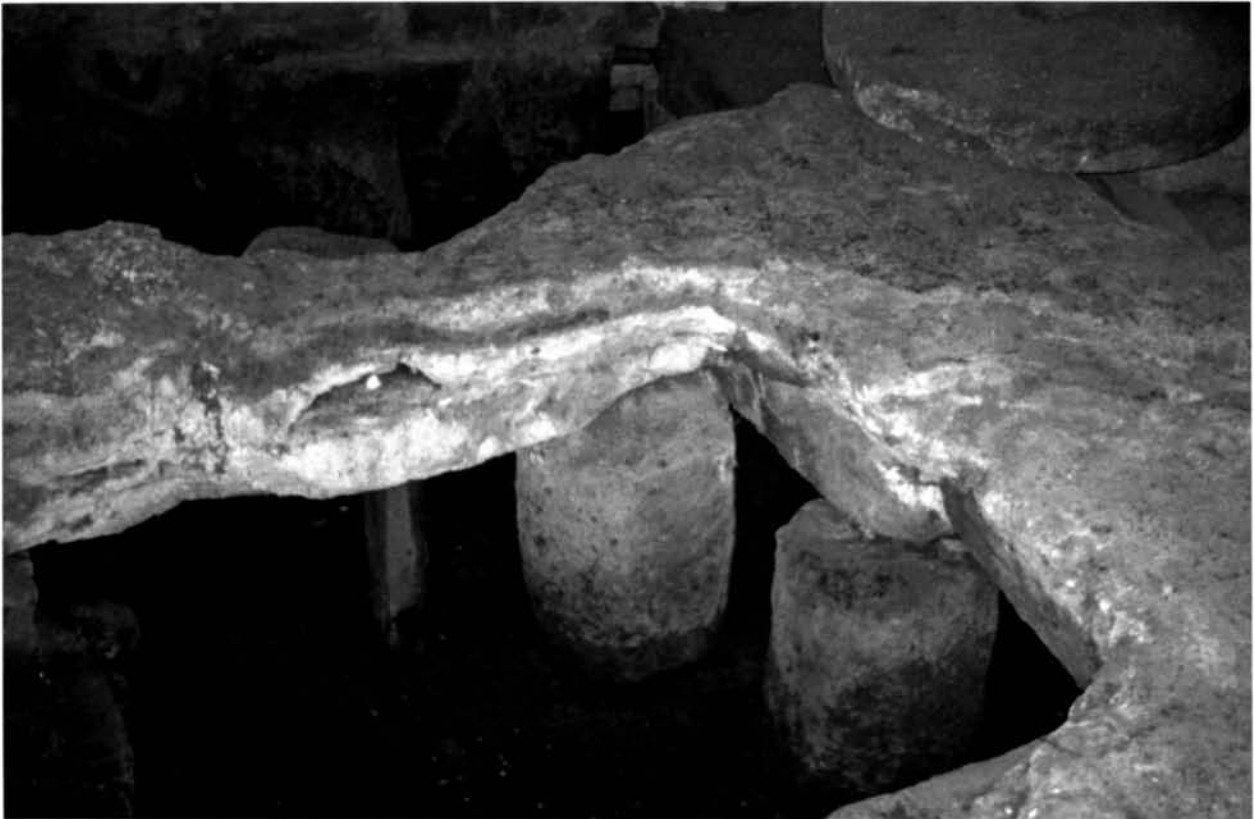
Fig. 8 - L'edificio di Sas Presones. Miliari che reggono il pavimento dell'ambiente 2.
